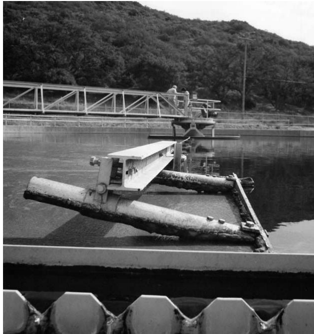
Слика 3.7. Уред за отстранување на масните од површината и прелив на ефлуентот кај кружен таложник
