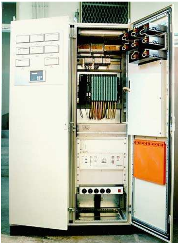
Слика 4.24: Фотографија на внатрешноста од управувачко ормарче за турбинска единица [41]
