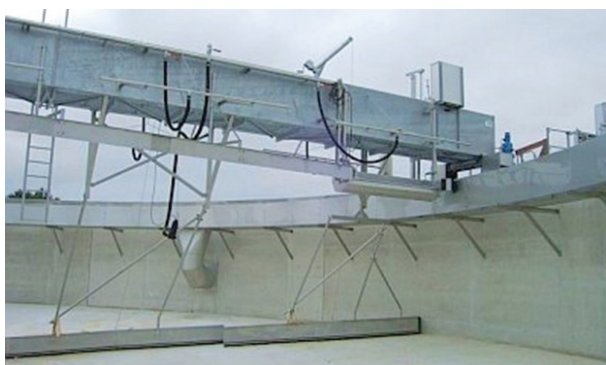
Слика 5.6. Механичка рака со која се носат исталожените цврсти материји кон центарот на таложникот [16]
