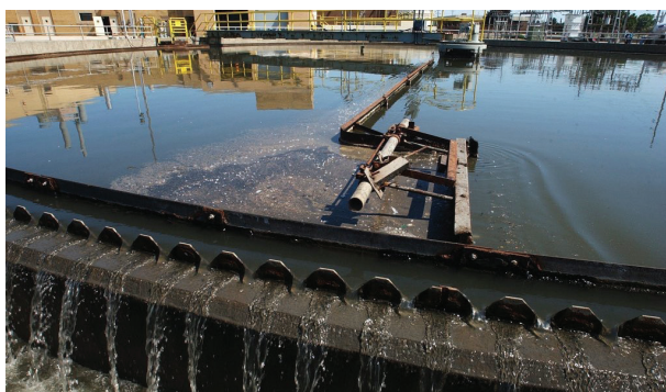
Слика 5.7. Уред за отстранување на мастите од површината и прелив на ефлуентот кај кружен таложник
